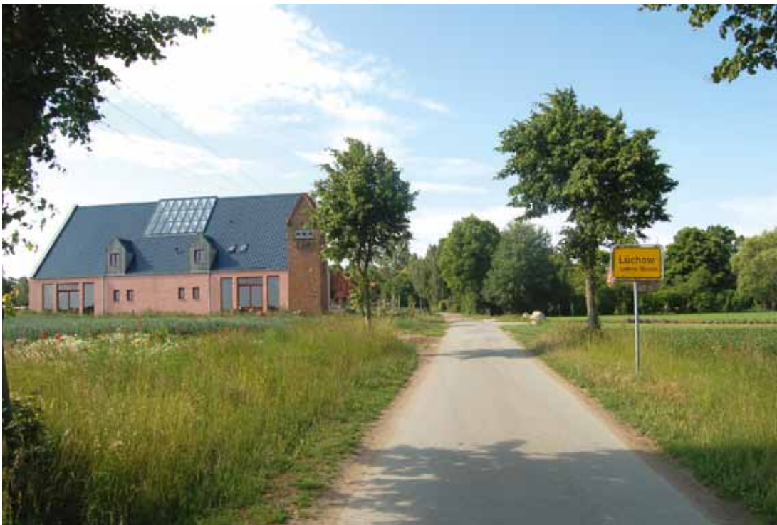
Das Schul- und Kindergartengebäude
